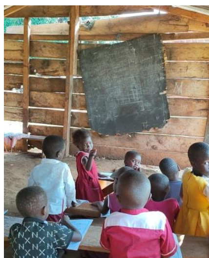
Aulas construidas en madera y paredes de adobe
